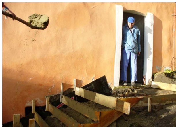
Oprava schodů do „Krauzáku“
